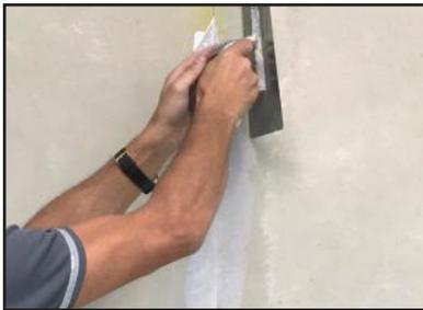
**Paso 3:** Aplique una primera capa de mortero en toda la zona de las juntas con espátula de 15 cm. Fije la malla de junta de 15 cm con el compuesto fresco, centrada en la junta y repase el mortero sobre ella cubriéndola totalmente. Evitar dejar excesos de mortero sobre la malla. **Dejar secar bien. Se recomienda dejar secar de un día para otro.**
